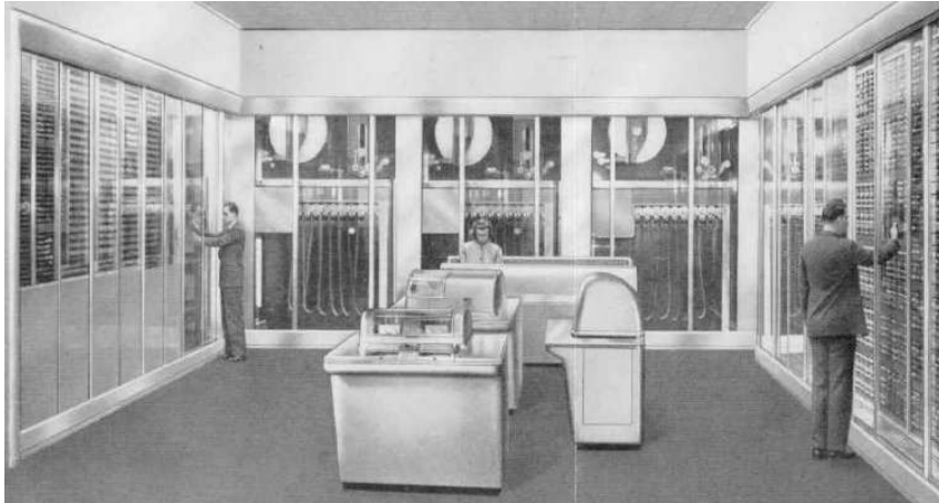
FIG. 1.2 – Opérateurs en salle des machines
